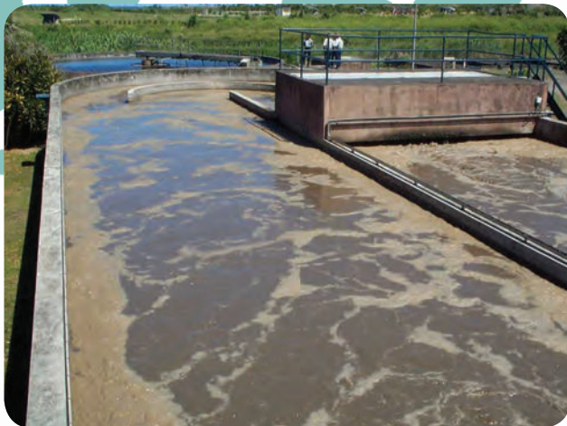
Couverture en béton au-dessous d'un pont-brosse
